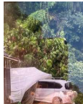
田野土砂崩れ、車庫に土砂流入
