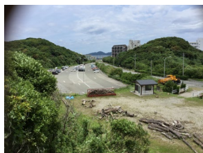
駐車場の拡張現場
